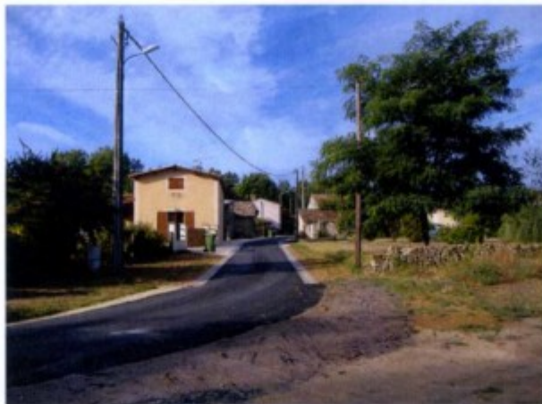
Quartier "Les Moulies" après les travaux 2012
